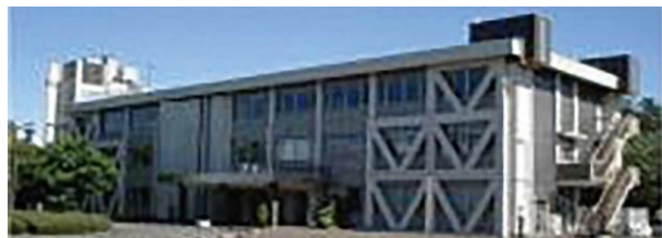
埼玉県農業技術研究センター
