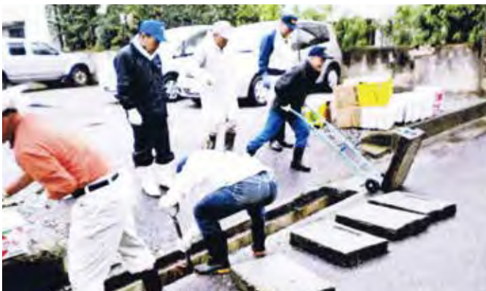
側溝の土砂・汚泥上げ：平成21年11月
