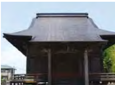
愛染堂の屋根修復
