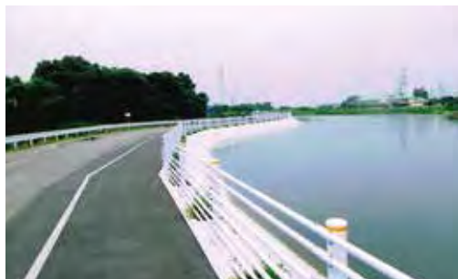
遊歩道整備の様子
